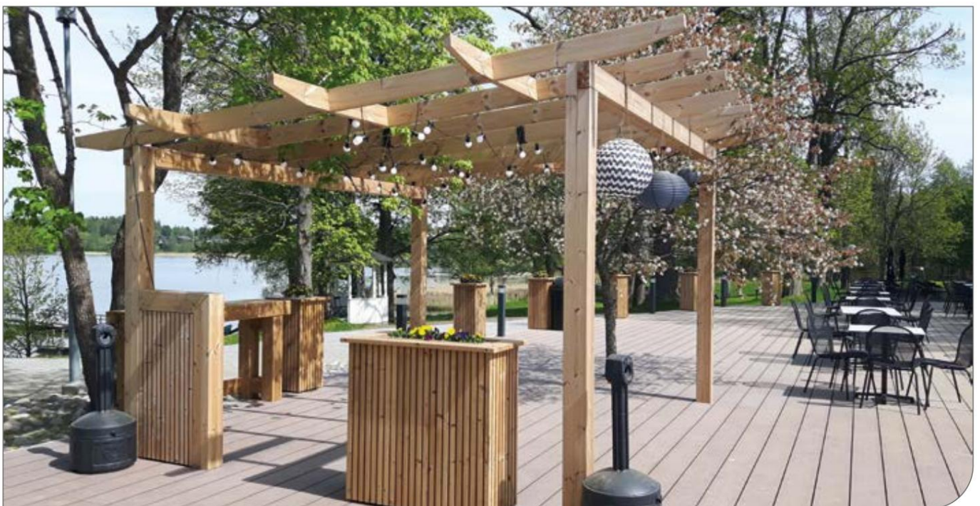
Figuur 33. ThermoWood®-balken verlijmd in een pergolastructuur
