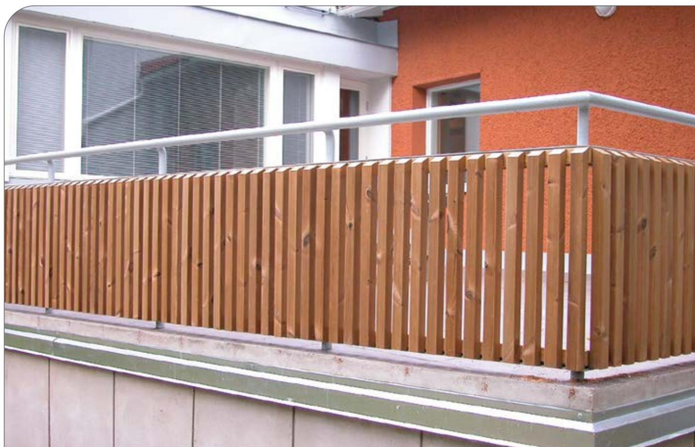
Figuur 66. ThermoWood® lamellen op balkonbalustrade.
