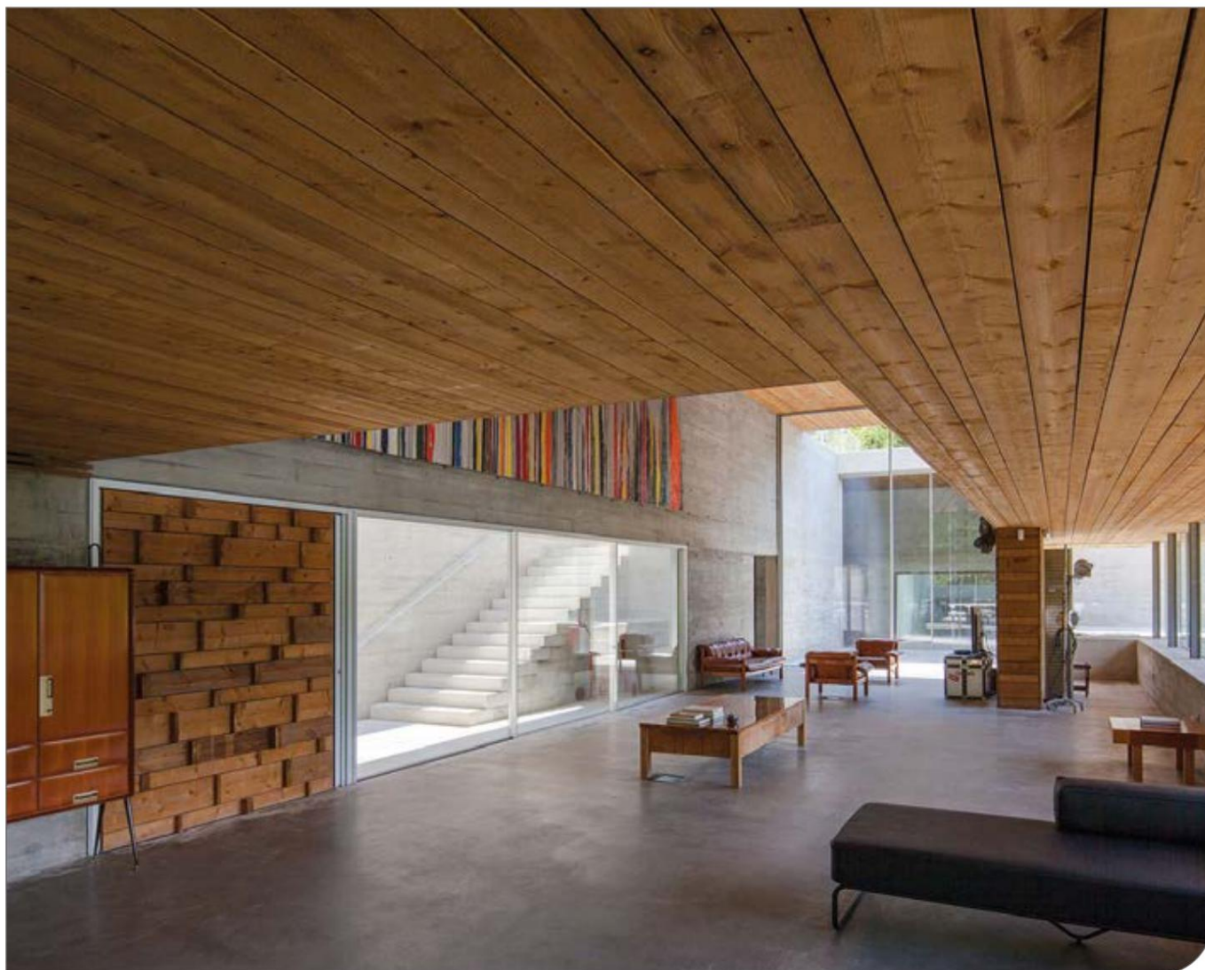
Figuur 38. ThermoWood®-plafond in Portugal.
