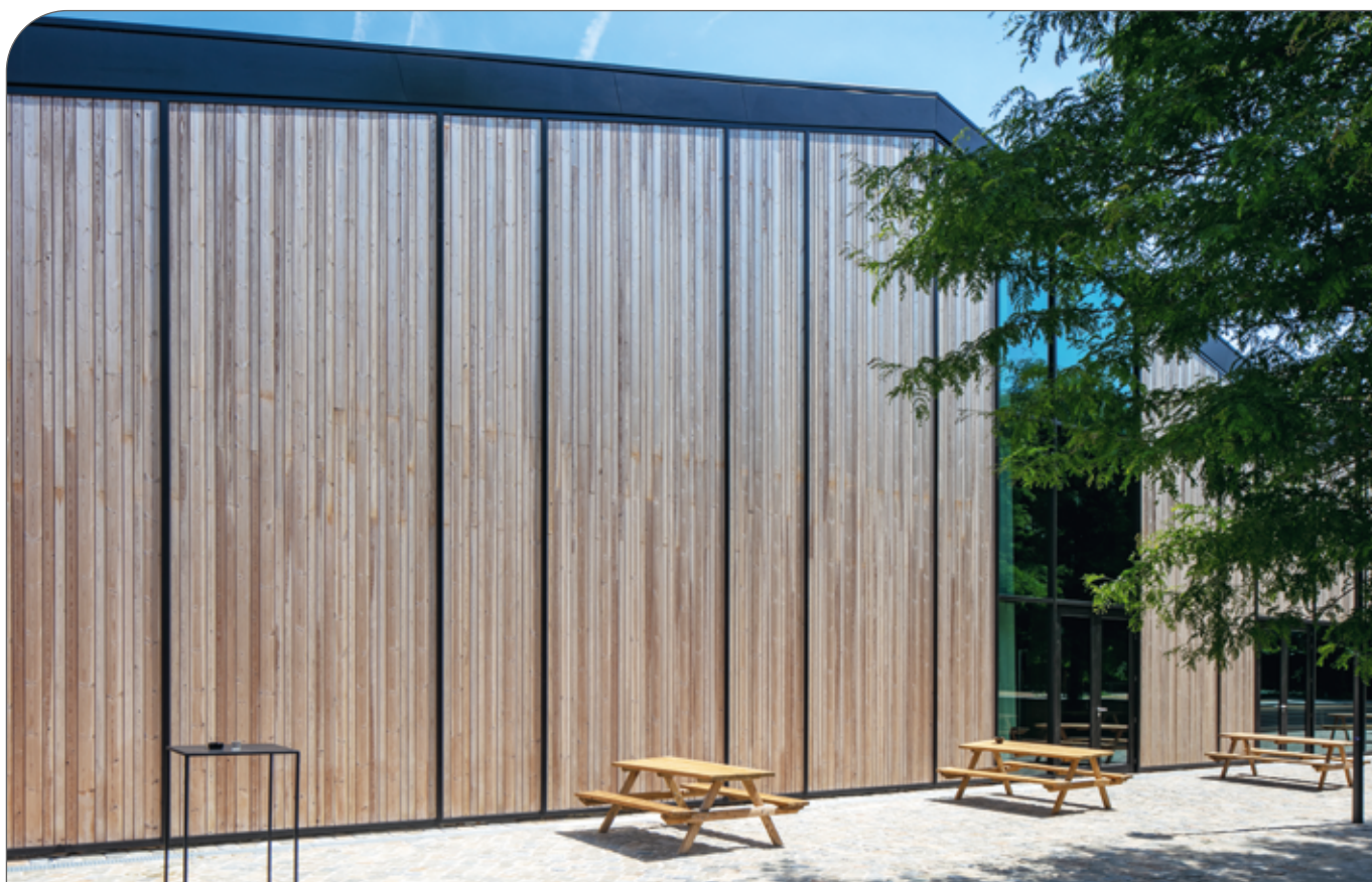
Figure 69. Bardage extérieur ThermoWood® (Belgique).
