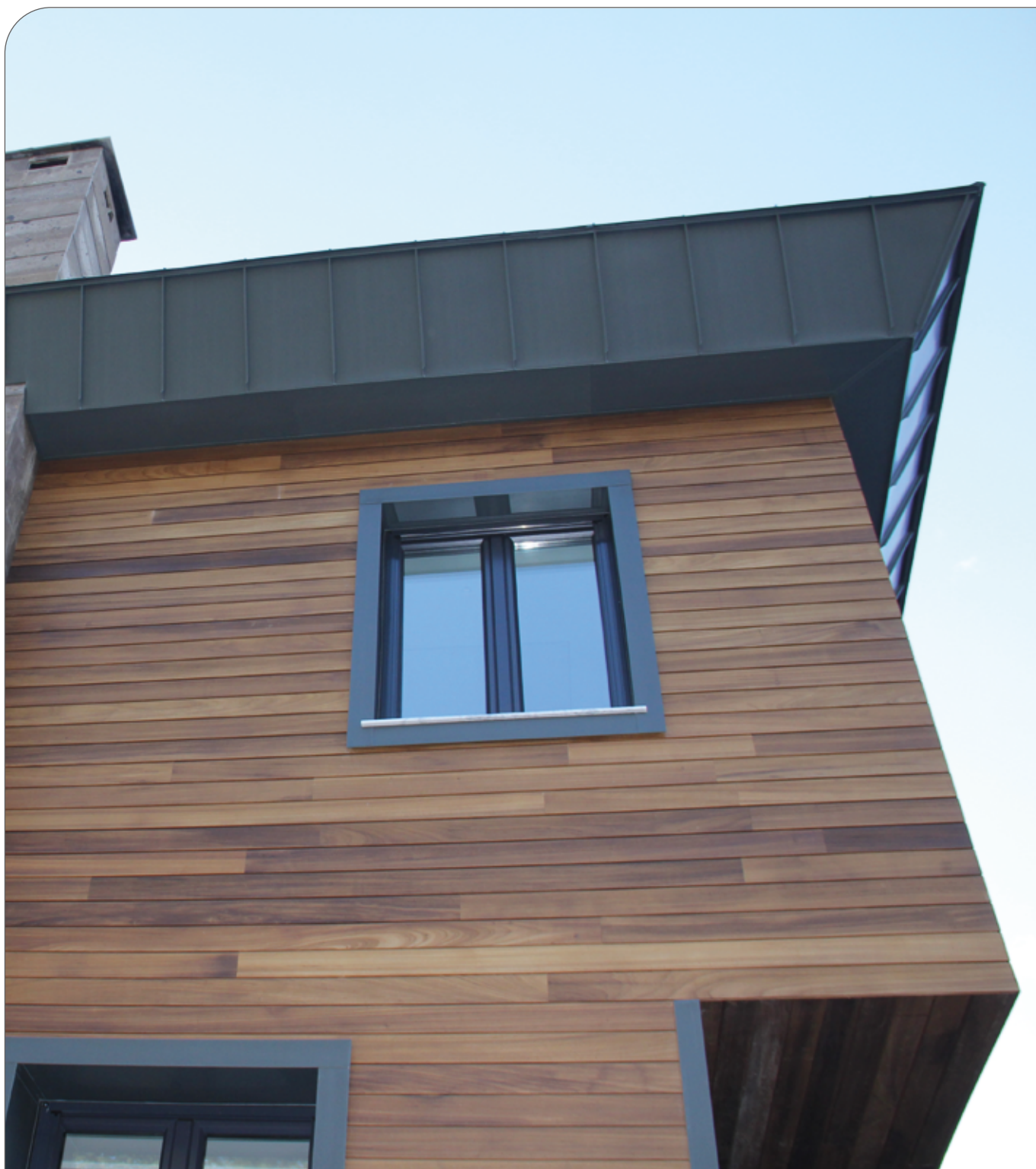
Figure 47. Bardage mural extérieur ThermoWood®.
