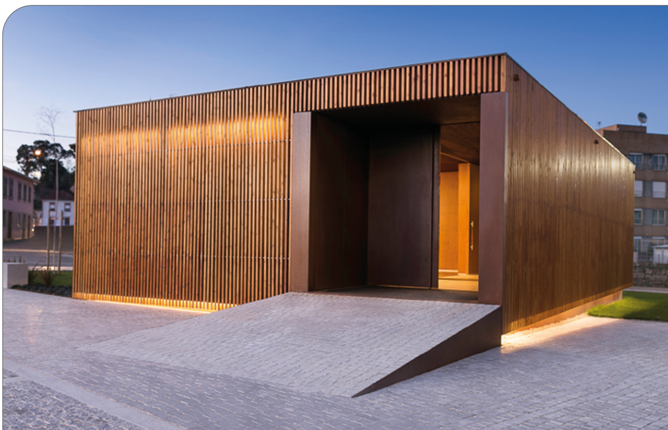
Figure 67. Bardage mural extérieur ThermoWood® sur une église portugaise.
