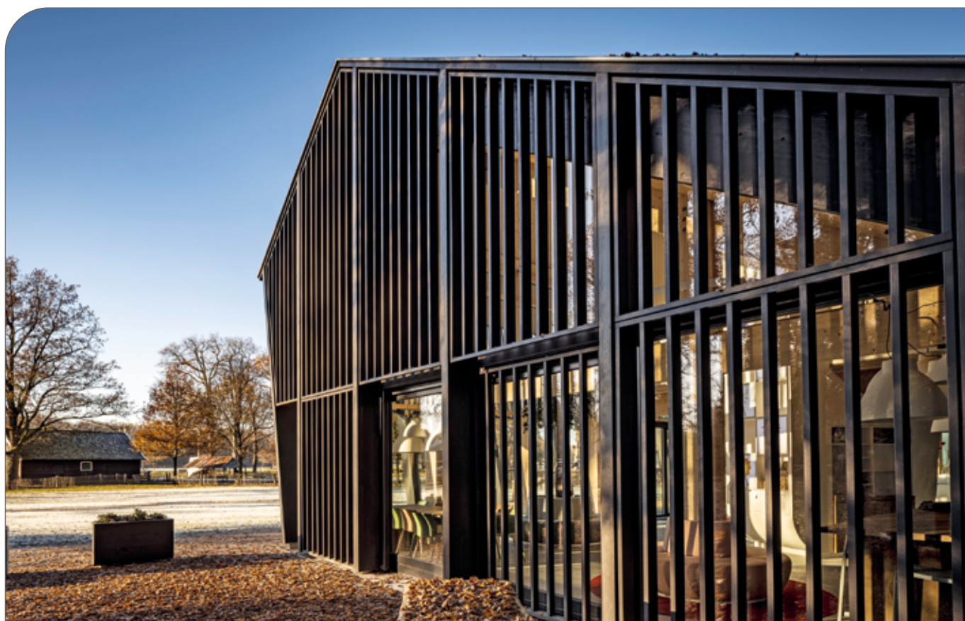
Figure 68. Bardage extérieur ThermoWood® (Pays-Bas).
