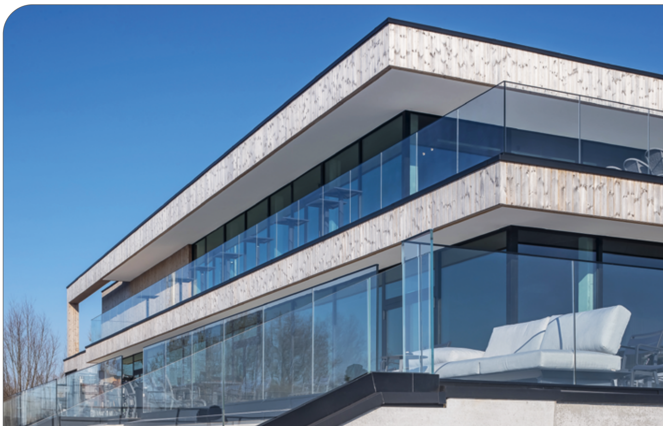
Figure 70. Bardage extérieur ThermoWood® (Belgique).
