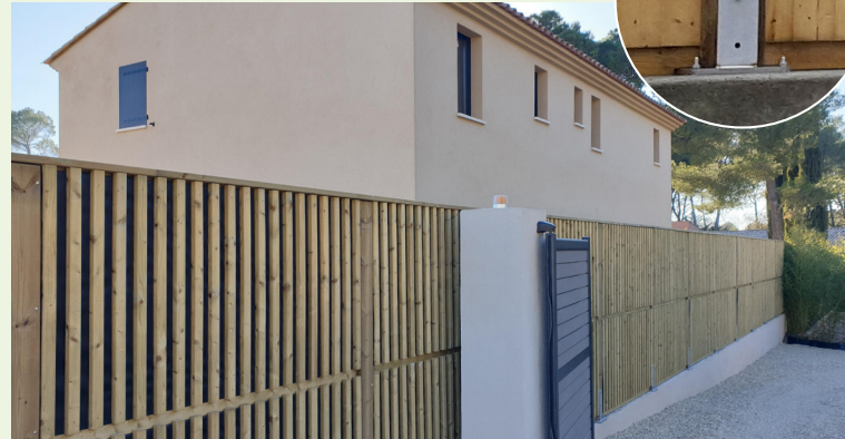
Illustration de montage sur platines
