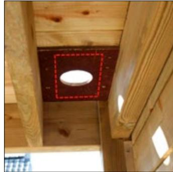
Pour assembler le panneau de contreplaqué, un trou doit d'abord être découpé dans le toit avec une scie sauteuse. La découpe dans le toit doit être plus petit que le panneau contreplaqué, ceci permettra de fixer le panneau contreplaqué par le dessus sur le bord de la découpe du toit.
