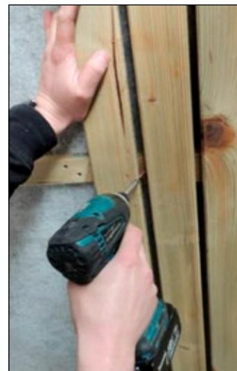
**Mur type 3 :** pour ce type de mur nous proposons des planches de 18 x 120 mm rainurés et languettes sur 2025 mm de long.
