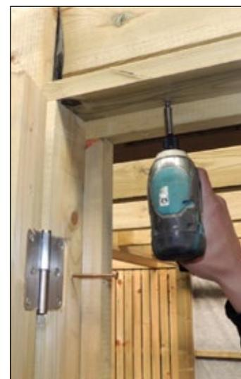
La vis centrale de chaque charnière de la porte doit être dévissé et remplacé par des vis plus longues de 50 mm.
