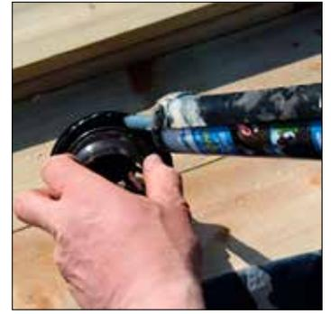
Couvrir la zone autour de l'évacuation avec de la colle EPDM (Aquaplan). Collez également l'EPDM sur le bord, de la même manière que le reste du toit.
