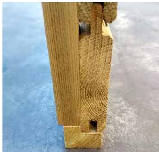
Vue détaillée : placement du mur sur le cadre de fondation.
