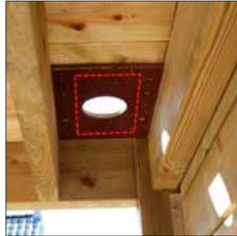
Pour assembler le panneau de contreplaqué, un trou doit d'abord être découpé dans le toit avec une scie sauteuse. La découpe dans le toit doit être plus petit que le panneau contreplaqué, ceci permettra de fixer le panneau contreplaqué par le dessus sur le bord de la découpe du toit. La ligne pointillée rouge représente le trou dans le toit.
