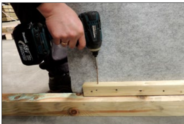
Schroef de panelen langs onder vast in de onderbalk. Met 2 schroeven 5x70mm.
