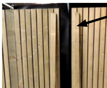
Schroef de panelen langs boven vast in de draagbalk. Met 2 schroeven 5x70mm.
