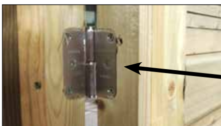
De middelste schroef van elke scharnier aan de kant van de paal of wand verwijderen en vervangen door langere schroeven van 50mm . (zie schroefzakje bij de deur)
