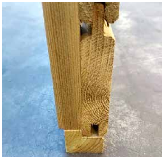
Detailweergave: plaatsing van de wand op de onderbalk.
